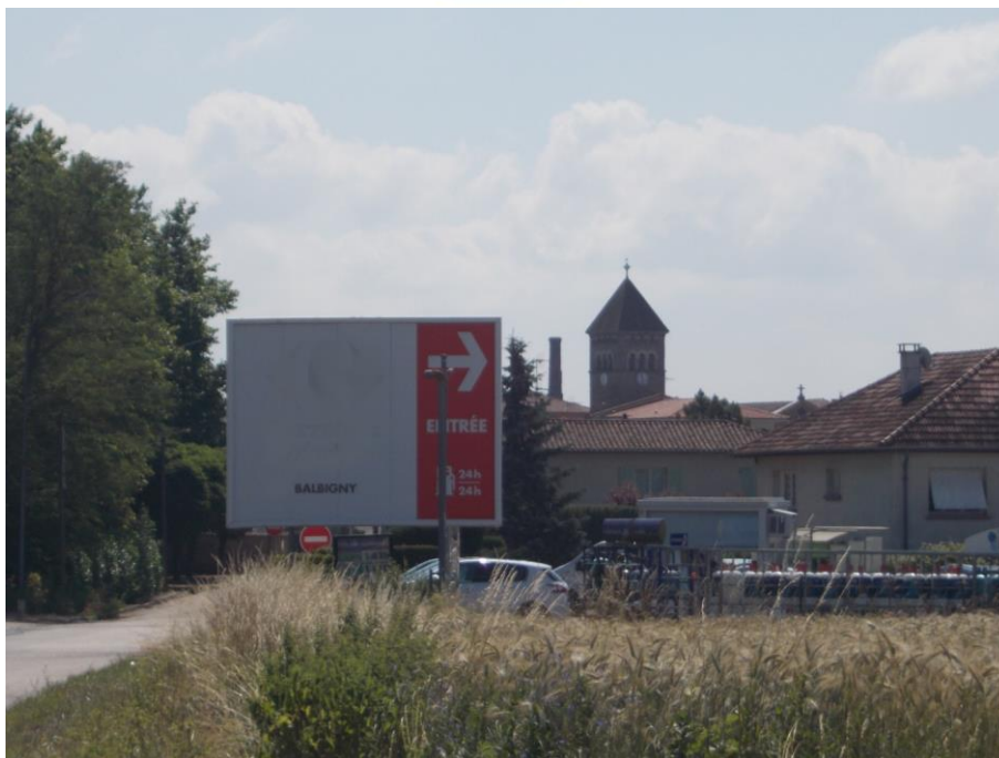
Covisibilité entre l'Eglise et une enseigne scellée au sol non conforme (12 m 2 au lieu de 6 m 2 ), rue de la Glacière
