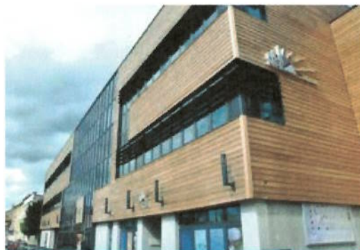
Siège du SIEL-TE à Saint-Priest en Jarez (42). Architecte : XXL Atelier
