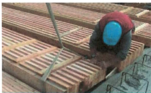
Mise en œuvre plancher Lignadal®.
