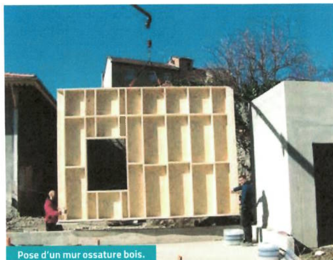
Pose d'un mur ossature bois.
